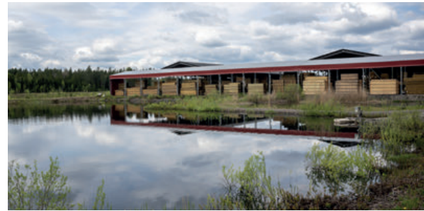
Damm för uppsamling av regnvatten som används till beredning av impregneringslösning.
